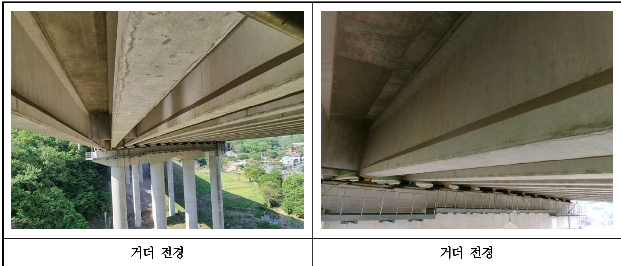
【사진 16.3.4】 거더 전경
