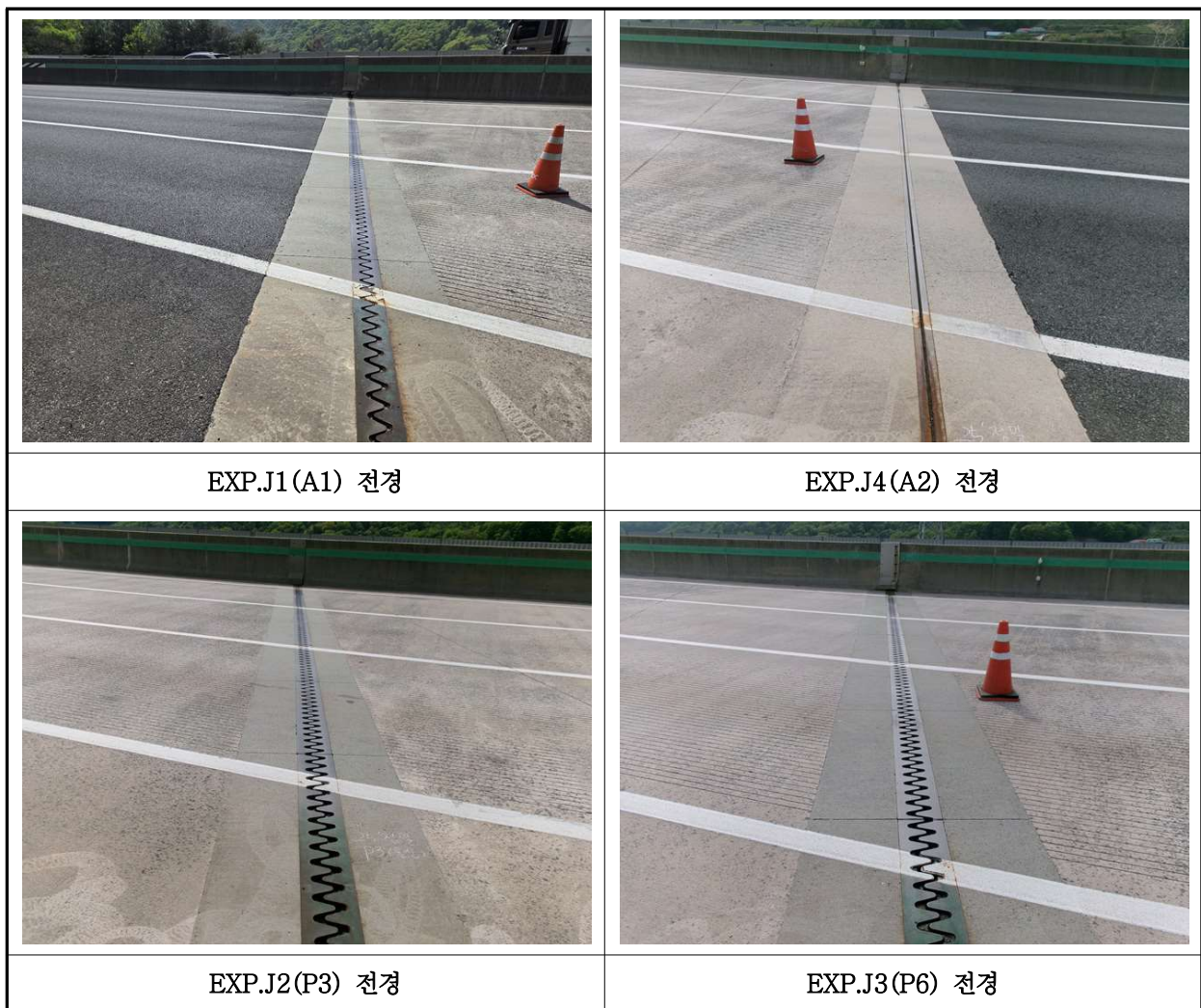
【사진 16.3.17】 신축이음장치 전경
