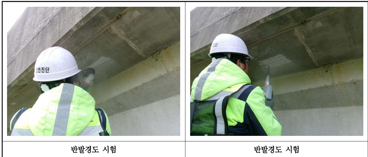
【사진 16.4.2】 반발경도시험 현장사진
