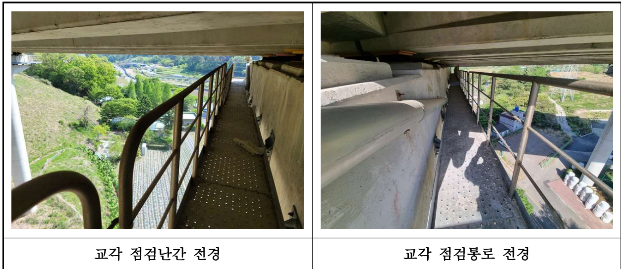
【사진 16.3.26】 교량 점검시설 전경
