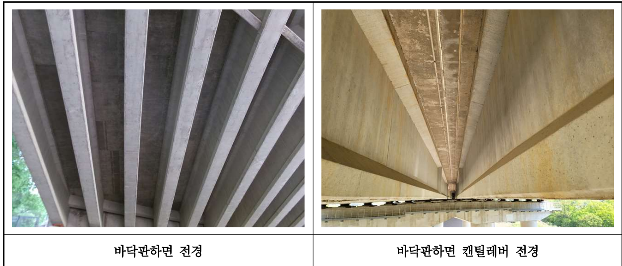
【사진 16.3.2】 바닥판하면 전경
