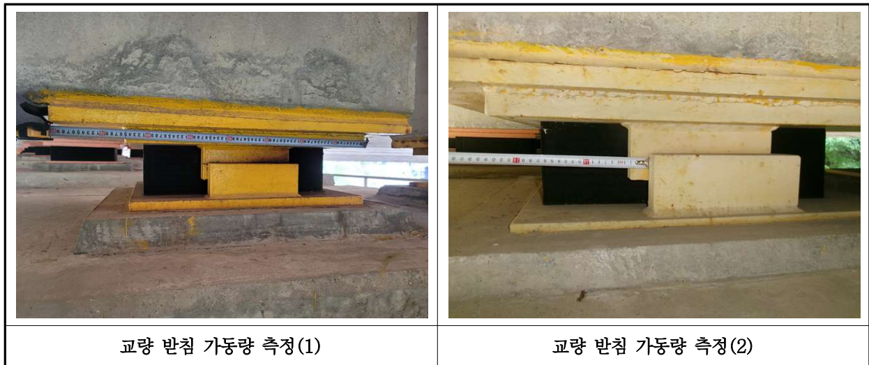
【사진 16.3.16】 교량받침 이동량 측정
