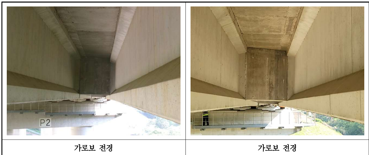
【사진 16.3.6】 가로보 전경
