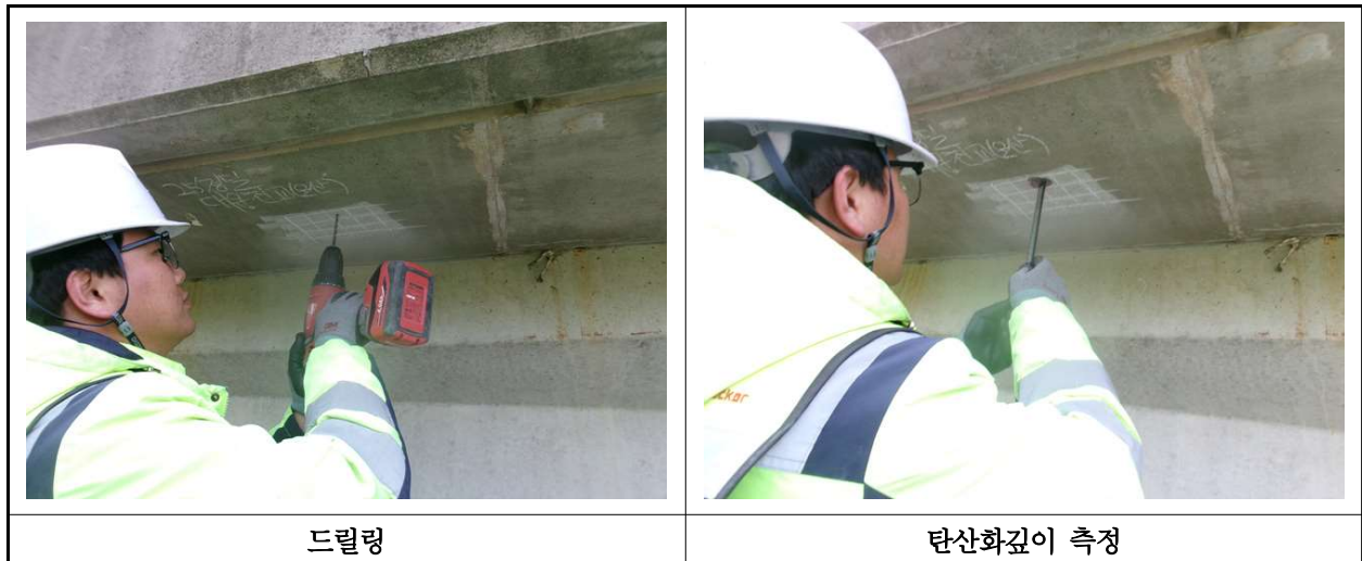
【사진 16.4.3】 탄산화 깊이 측정 현장사진
