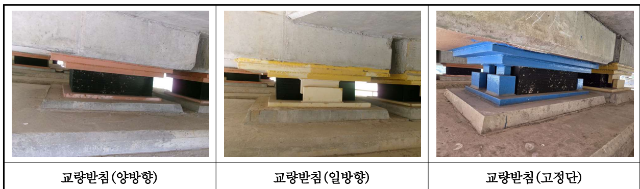
【사진 16.3.13】 교량받침 전경
