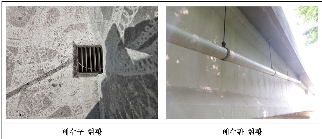
【사진 16.3.22】 배수시설 전경
