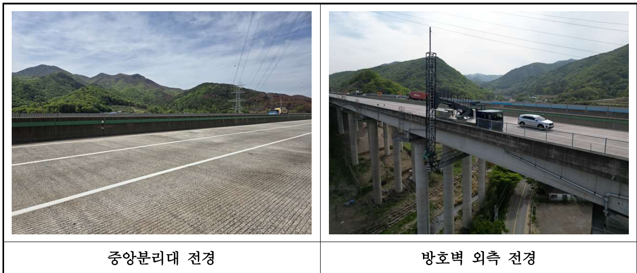
【사진 16.3.24】 방호벽 및 중분대 전경
